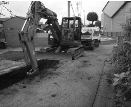
下水道管渠布設工事
