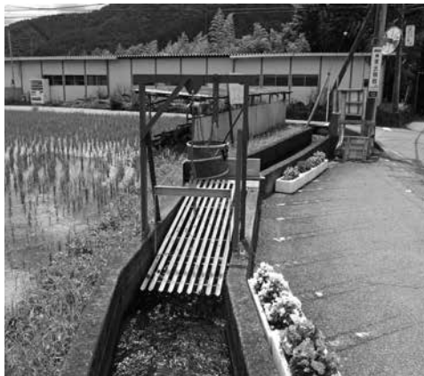
町内に設置された除塵機
