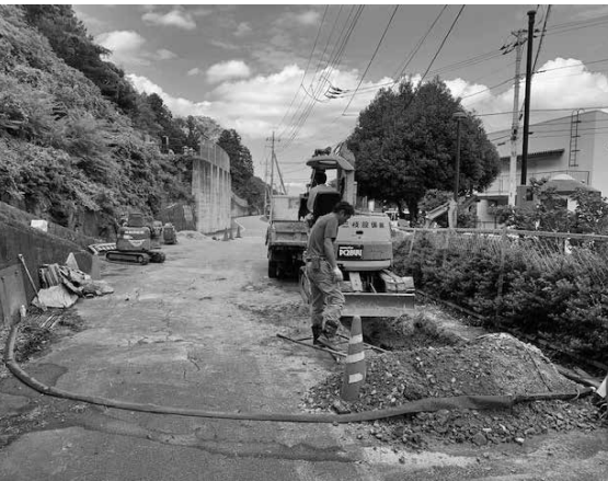
水道本管漏水修繕工
