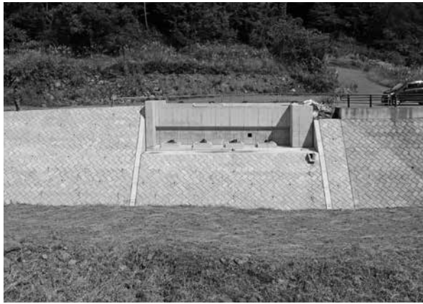
令和元年度施工した（仮称）宮作橋下部左岸工事
