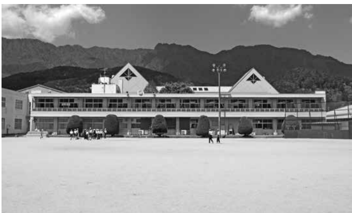
太陽光発電システムを設置する「小学校南館校舎」
