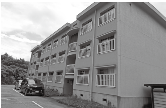
水回り等改修工事を行う中野団地1号棟地
